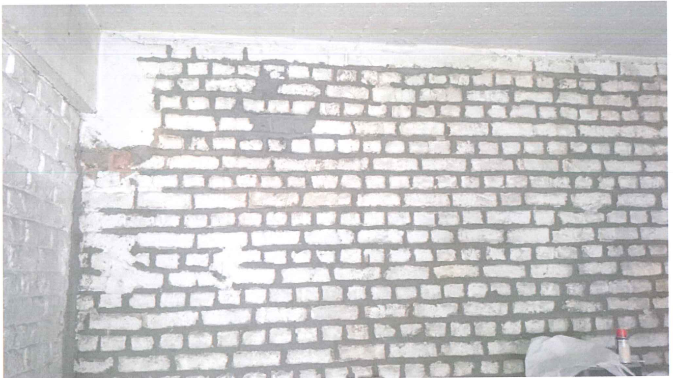
Mur du fond du garage, non concerné par le litige
